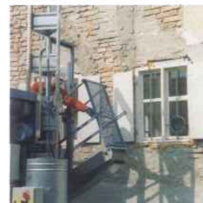
Mit dem Montagesteg (nachrüstbar) kann die Transportbühne auch ohne vorgebautem Gerüst verankert werden.
