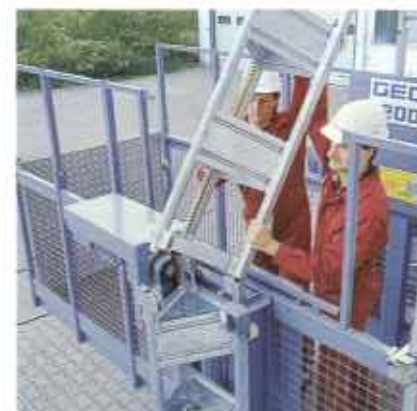
Bequemes Aufsetzen der 1,5 m hohen Stahlmaste (feuerverzinkt) mit unverlierbaren Schrauben und gesicherten Muttern.
