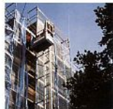
Ferrelle és függőleges lépcsők felrakása és fogaskerék szerelése
